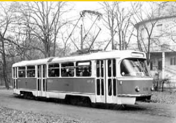
Pražský vůz č. 6110 z první série tramvají T3, dodané ve druhé polovině roku 1962. Fotografie pochází z někdejší smyčky Park Julia Fučíka (dnešní Výstaviště) a dokumentuje tovární provedení nejstarších vozů T3.
