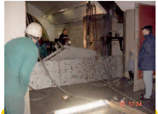
Usazování uzávěru bylo složitou záležitostí. Na desku se přivařilo několik pomocných ok, za která se uzávěr přiváděl. Jejich umístění se měnilo se změnou těžiště zvedané desky.
