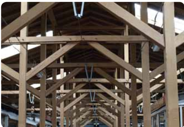
Pro střešovickou vozovnu byla vždy typická střešní konstrukce podepřená dřevěnými sloupy. Dochovala se beze změn dodnes.
