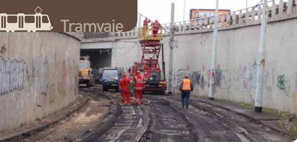
První hodiny po ukončení tramvajového provozu byly ve znamení práce provozu Vrchní vedení a také již probíhala likvidace asfaltového povrchu. Foto: Jan Šurovský
