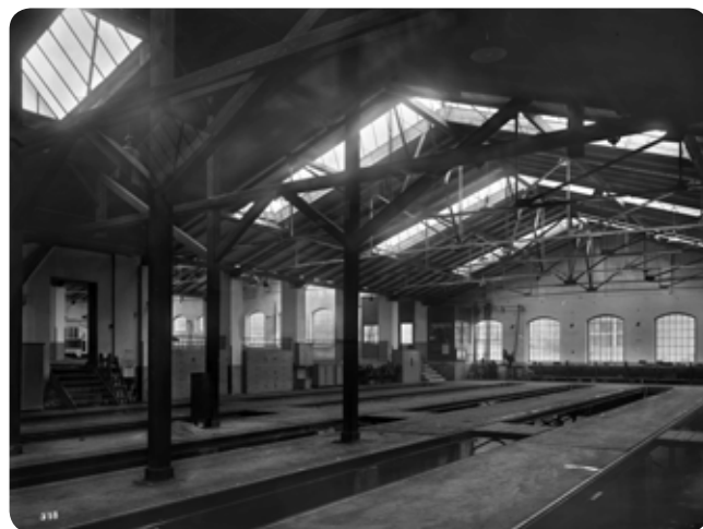
Části tří lodí přistavěné v roce 1930 mají železné krovky bez nosných sloupů. Na snímku jsou dobře vidět původní průhledy mezi 2. a 3. halou. Do budoucna se počítá s jejich obnovou.
