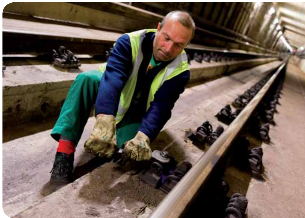
Luboš Večeřa v rámci své noční pochůzky vyměňuje prasklou svěrku v uchycení kolejnice k pražci
