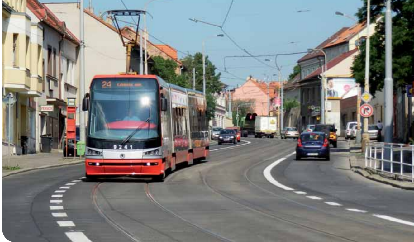
V horní části Zenklovy ulice byla tramvajová trať zřízena na betonové desce s živičným krytem. Pamatujete? Právě v těchto místech byly omezené rychlosti
