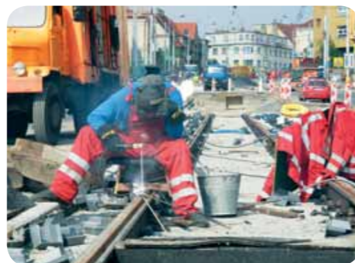
Práce svářečů. V tomto místě nad Vychovatelnou přechází otevřený svršek na zakrytý
