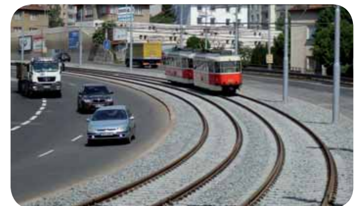
Tramvaj stoupá od Bulovky k Vychovatelně po trati s otevřeným svrškem. Obyvatelé okolních domů už netrápí hluk z projíždějících tramvajů
