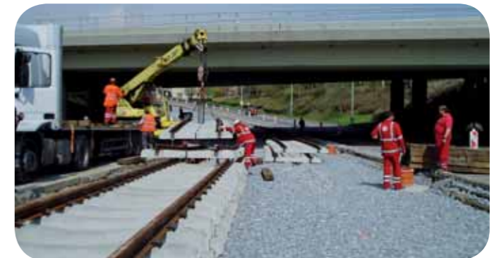
Za Bulovkou začíná pokládka kolejových polí s kolejnicemi S49
