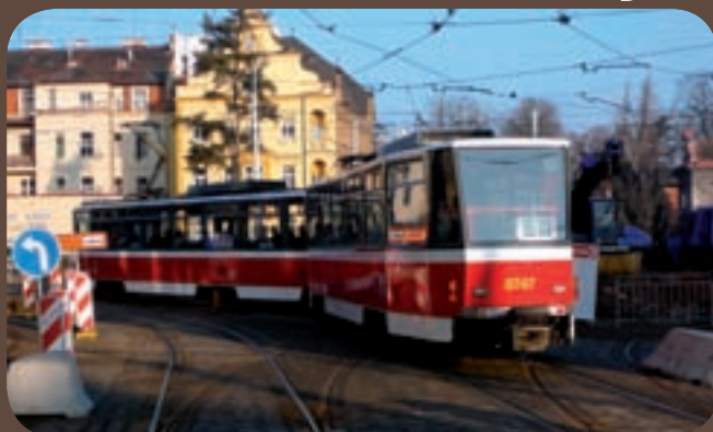
Tramvaje na křižovatce Špejchar v posledních dnech provozu projížděly staveništěm.
