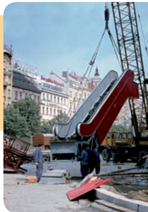
Montáž eskalátoru Otis u Wiehlova domu na Václavském náměstí 18. července 1968. Na snímku je vlevo vidět i část příhradové konstrukce eskalátoru Radnik.
