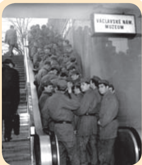
Vzácný snímek z provozních zkoušek prototypu eskalátoru pro pražské metro na Václavském náměstí 8. září 1971
