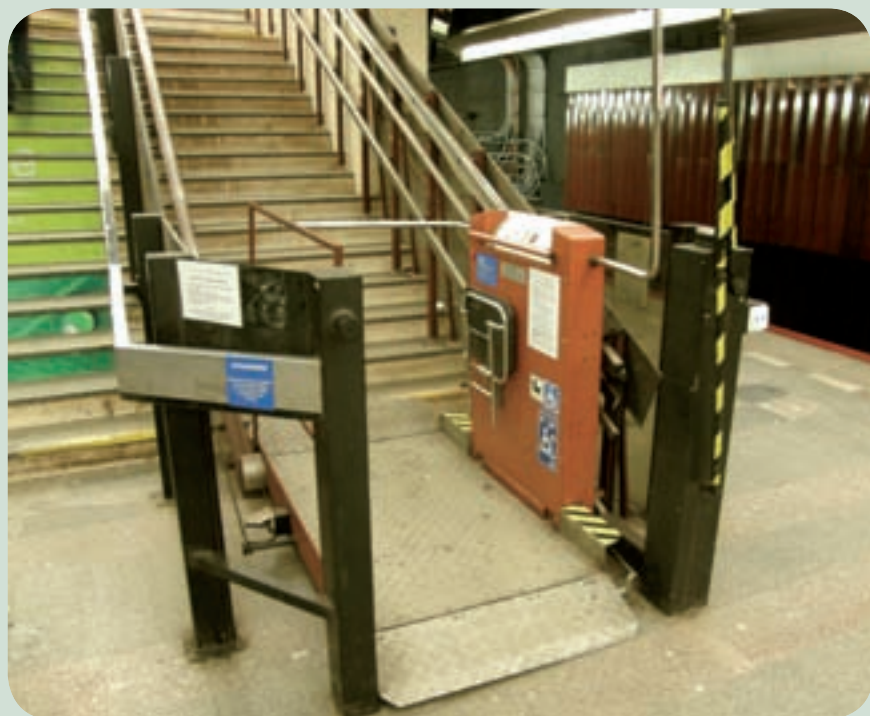
Šikmé plošiny jsou častým terčem útoků vandalů. Zejména poškození mechanických závor a zábran. Ilustrační foto je ze stanice Strašnická.
