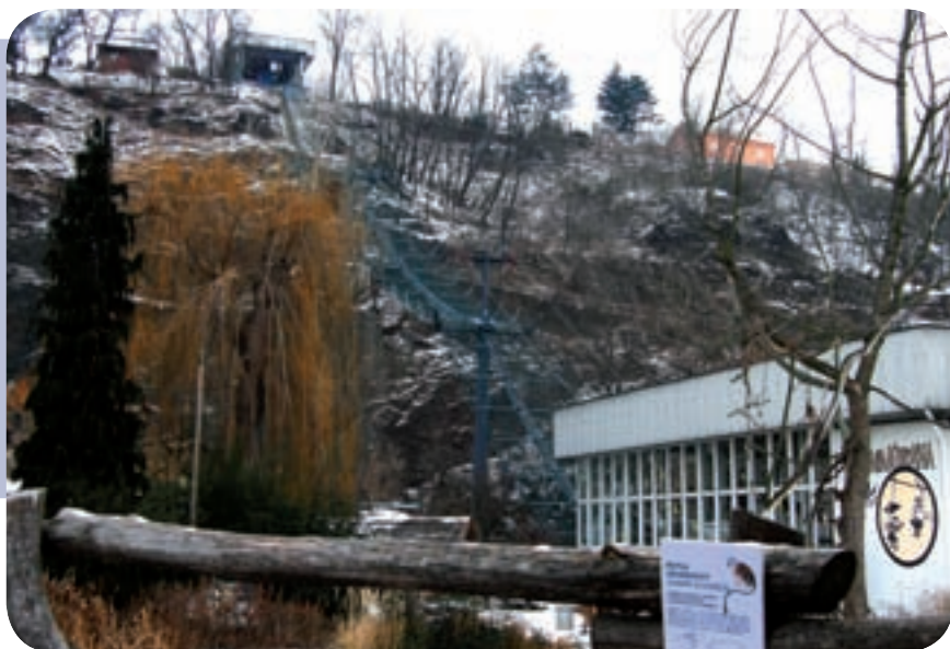
V zimním období je lanovka v ZOO mimo provoz. Všechny sedačky jsou demontovány a uloženy v dolní stanici.
